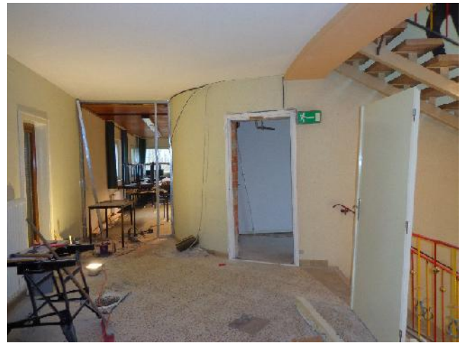
de houten deuren worden verwijderd en worden vervangen door brandweerdeuren komen
